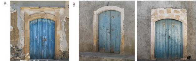
Παραδείγματα τοξωτών πλασιών θυρών με πελεκητή πέτρα
